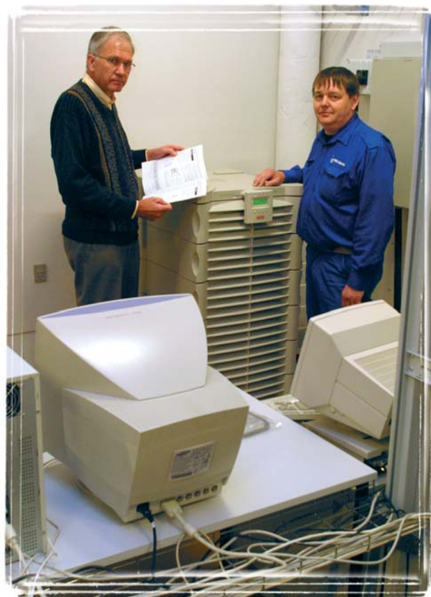
Netværkschef Gunnar Hansen, Syddansk Universitet, (til venstre), og datatekniker Frank Boeriths fra Dansk Datanet besigtiger det nye UPS-anlæg, bestående af to APC Symmetra 16 kVA.
